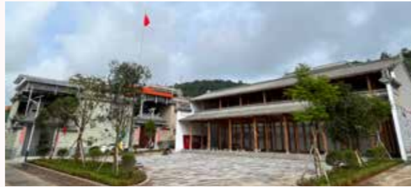
▲ Square culturel du village de Pingyi du district de Lianghe, construit avec l'aide de la CNMC
