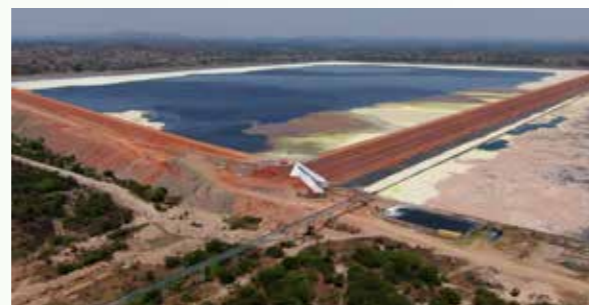
▲ Bassin de résidus de Muliashi de la CNMC Luanshya Copper Mines PLC
