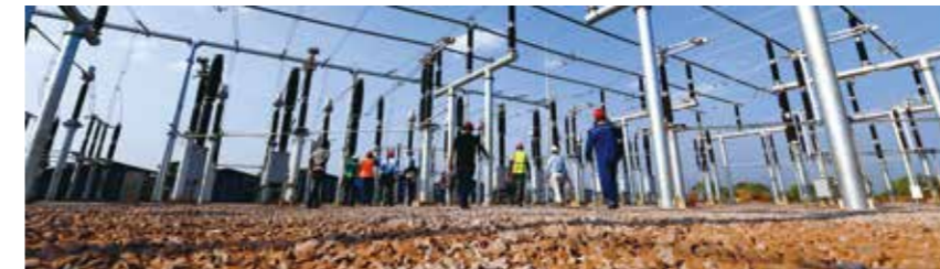
▲ La Lualaba Copper Smelter SAS (LCS) et la State Grid Corporation de la République démocratique du Congo construisent ensemble une sous-station à Kolwezi située dans le sud du pays
