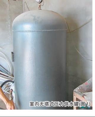
室内无塔式压力供水罐(图1)
