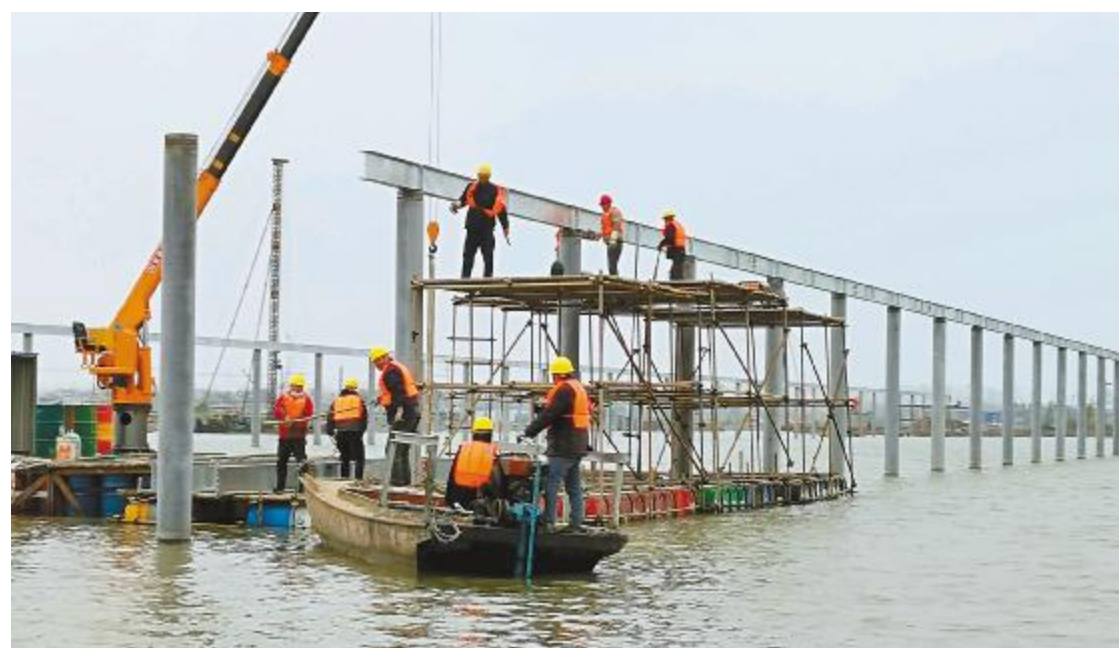
项目施工现场
