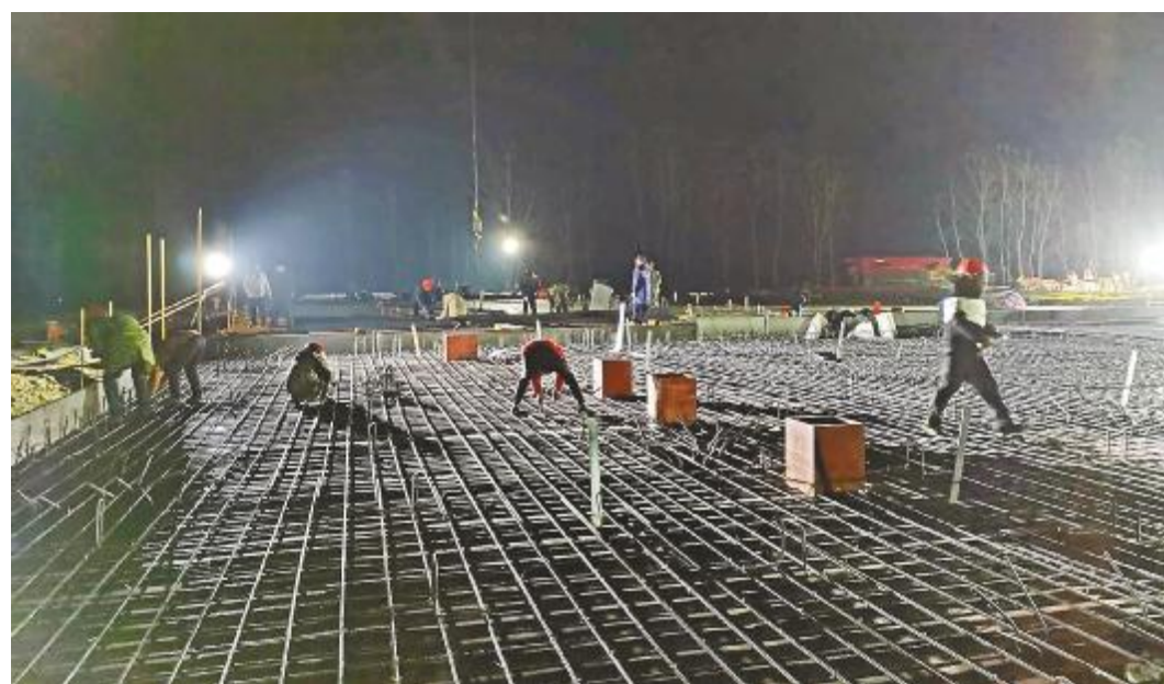
施工质量、建设进度“两手抓、两手硬”
