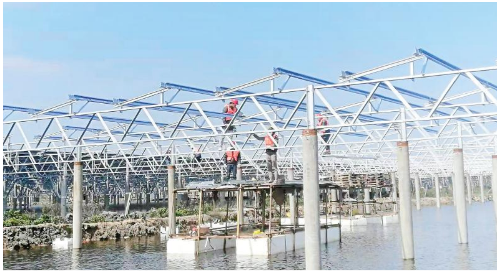
“渔光一体”项目建设现场
