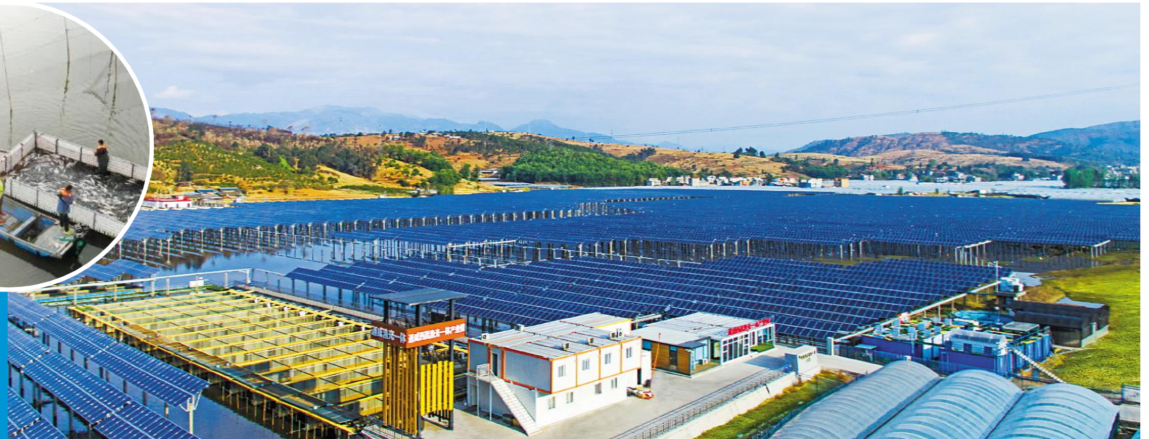
通威西昌“渔光一体”基地
