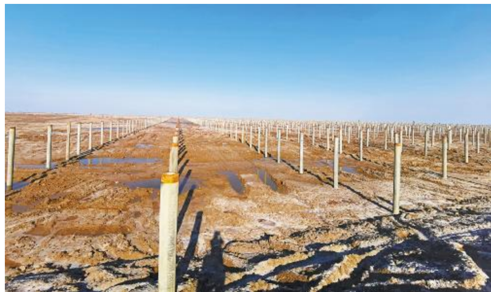
通威东营项目打桩“一线天”
