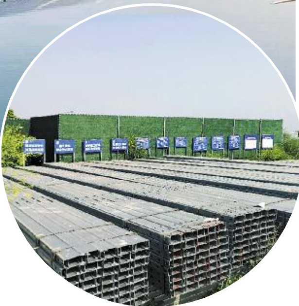
实施标准化管理的常德项目现场物料堆放整齐
