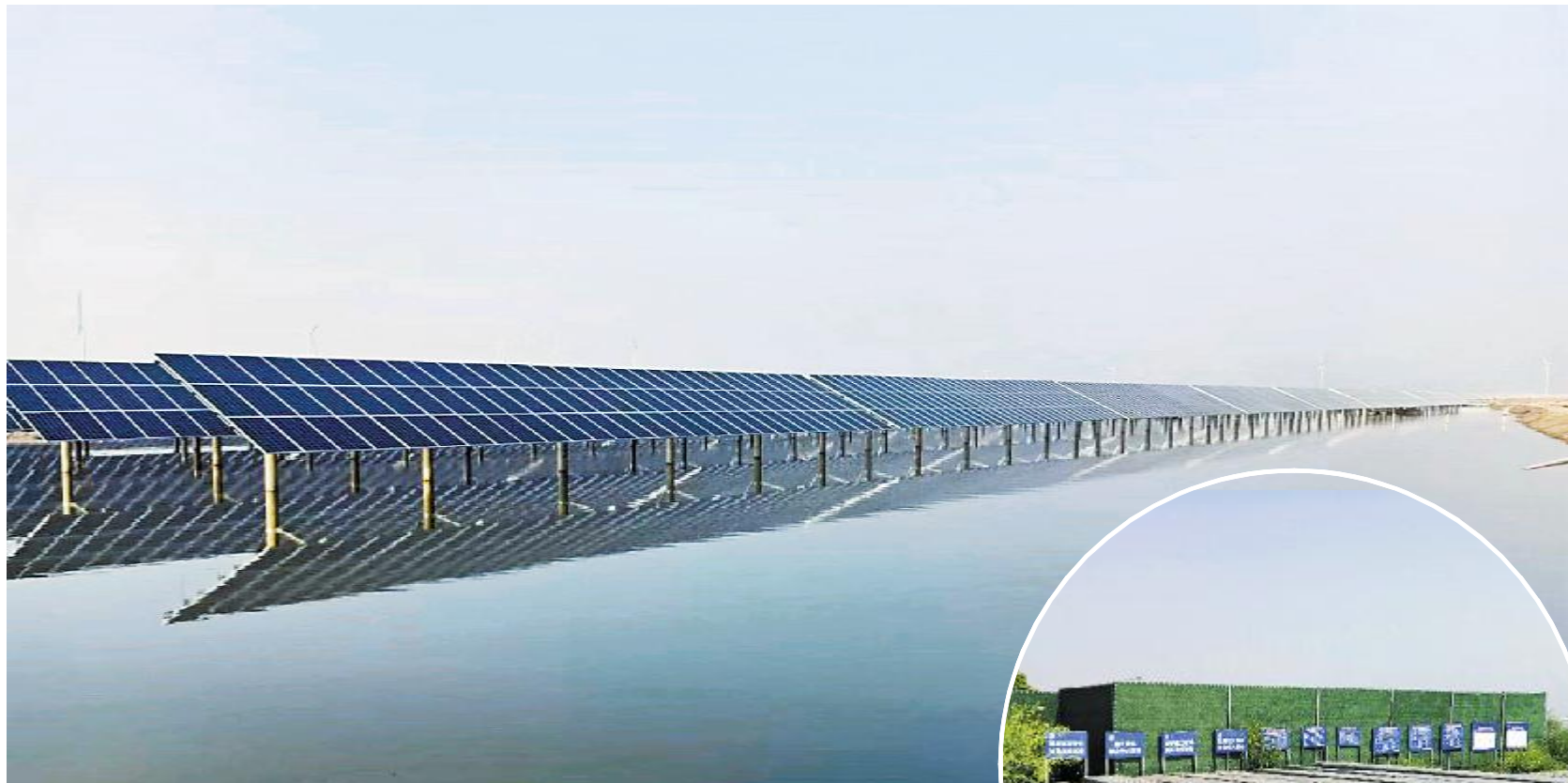
通威滨州沾化项目建设现场
