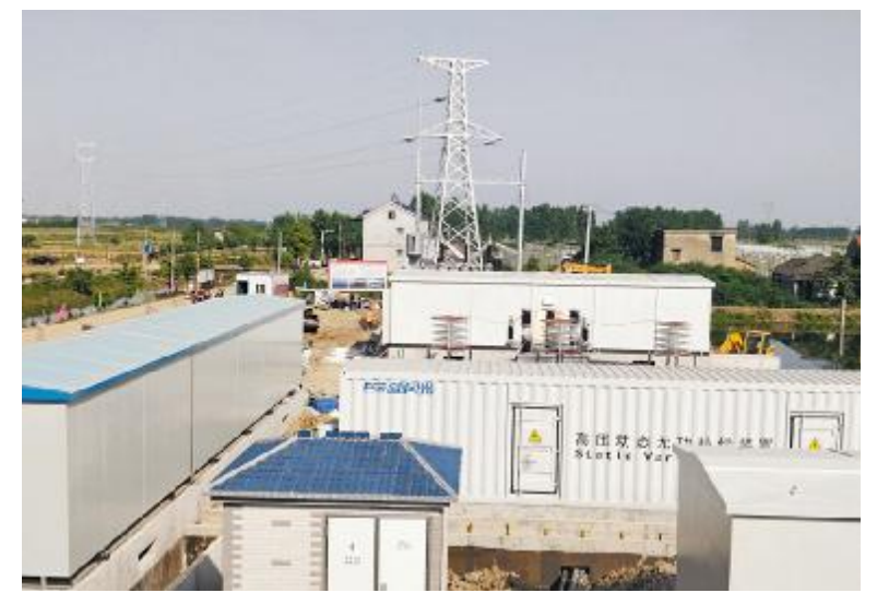
通威湖北公安项目升压站建设现场
