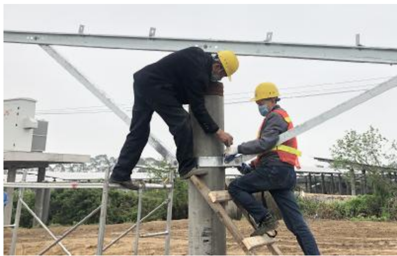
广西钦州项目施工现场
