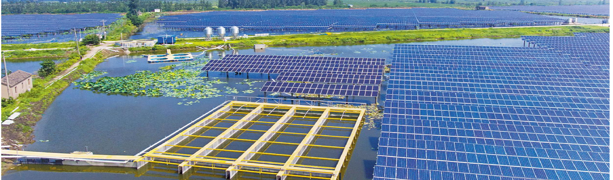
通威和县“渔光一体”基地
