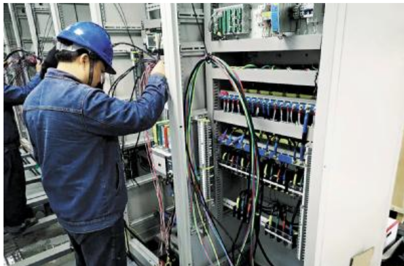
湖南常德项目二次电缆接线
