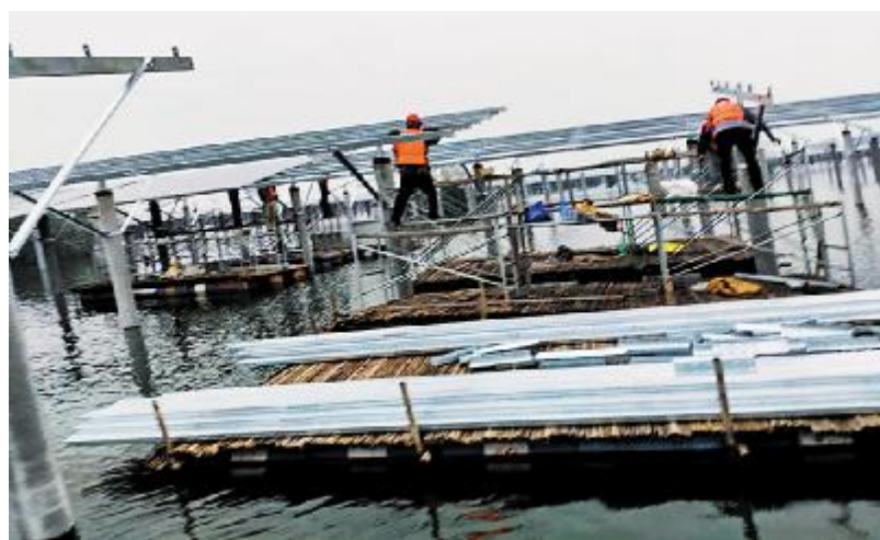
江西高安项目支架安装
