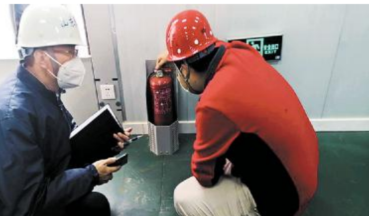
消防器材检查
