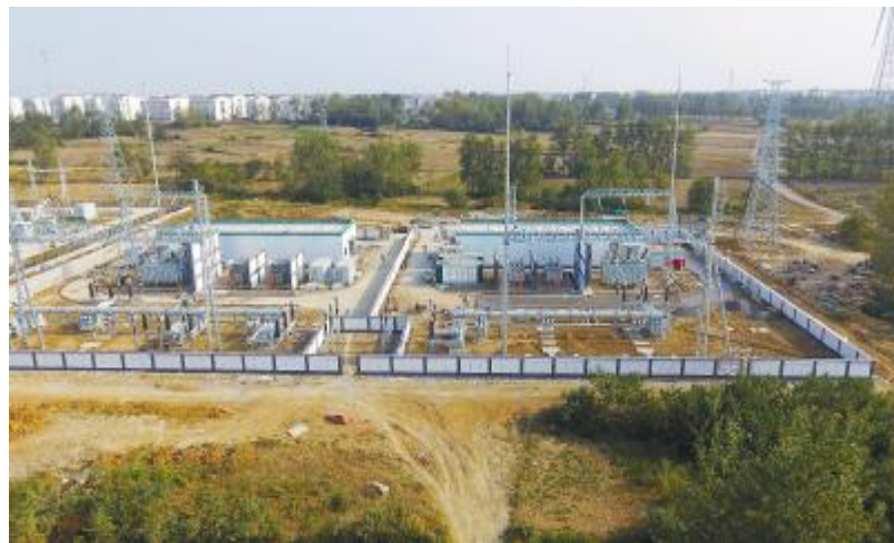
升压站建设现场
