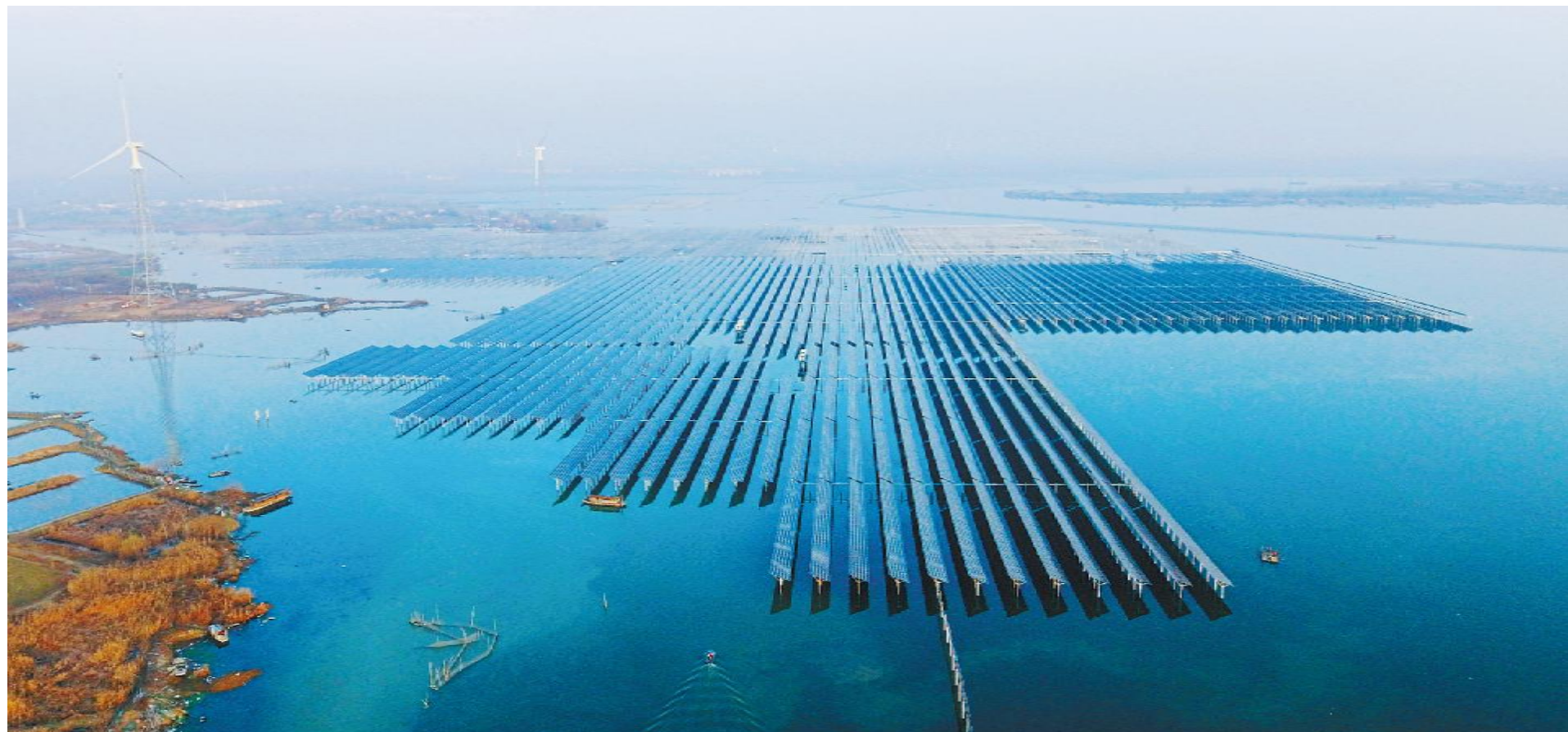
通威泗洪“渔光一体”项目
