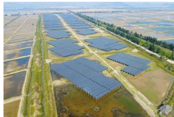
通威广东省江门市台山市汶村镇“渔光一体”项目
