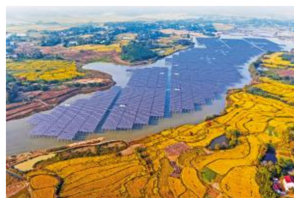
通威安徽省安庆市怀宁县方家湖“渔光一体”项目
